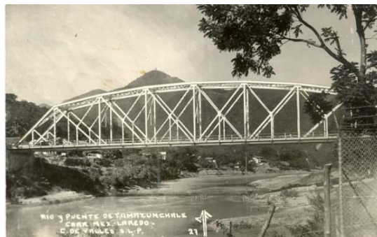
Figura 2. Puente Metálico sobre el Rio Moctezuma, construido en 1935, bajo el mandato del Presidente Lázaro Cárdenas del Rio.
